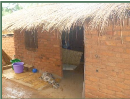
Het schoolgebouwtje bestaande uit 1 lokaal
