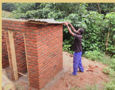
Stap 3: tijd voor het dak. Plaats balken en bevestig golfplaten
