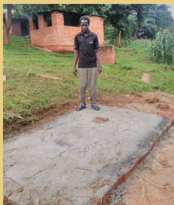
Stap 1: graaf een diepe put en bedek deze met een laag cement met 2 gaten in.
