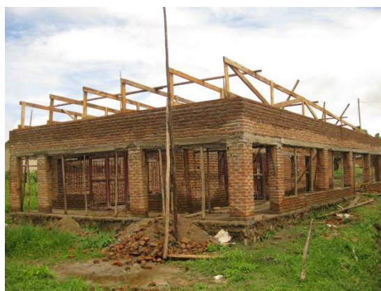
Het nieuwe pand in aanbouw
