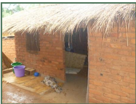
Het schoolgebouwtje bestaande uit 1 lokaal
